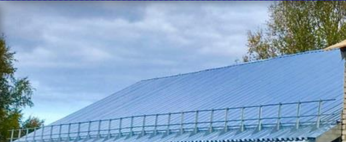
Ремонт кровли Каменниковской школы
