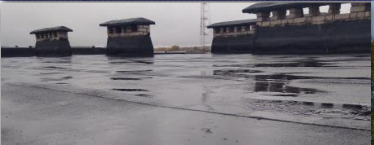
Ремонт кровли Октябрьской школы
